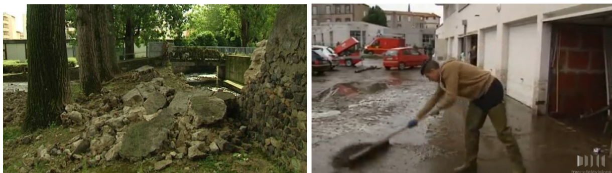
Le samedi 9 août 2014, suite aux violents orages, le mur séparant la Tiretaine du collège privé Saint-Alyre, à Clermont-Ferrand, a explosé sous la pression de l'eau. L'eau a également envahi les garages des immeubles situés à proximité (photos France 3 Auvergne)
